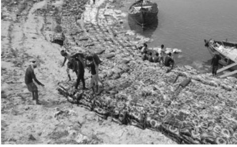
চিত্র ৭: নদীর পাড় মজবুত করতে নাইলনের দড়ি ও বালির বস্তার ব্যবহার (উৎস: ক্ষেত্র সমীক্ষা ২০২৪)
